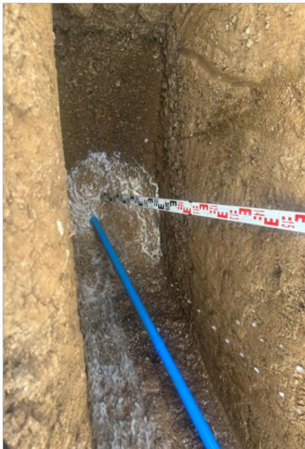
Foto 3: SG 1.2 beim Einfüllen von Trinkwasser
