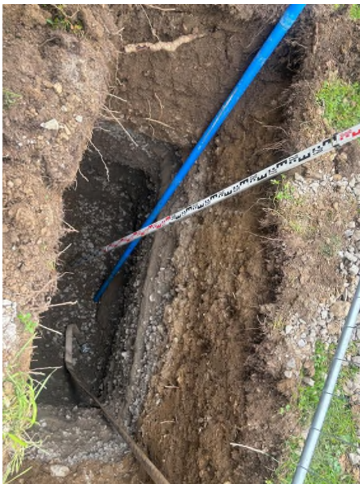
Foto 7: Schürfgrube 2.3 vor Versuchsdurchführung
