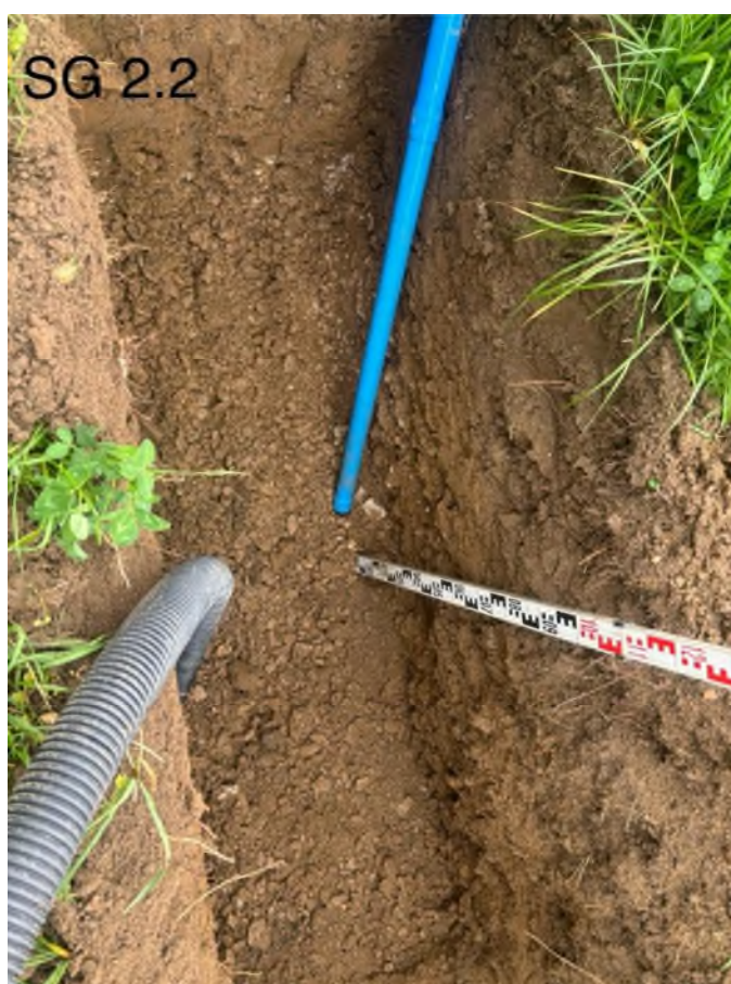
Foto 6: Sohle SG 2.2 vor Versuchsausführung
