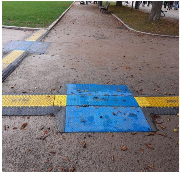
Bild rechts: Immer mehr Preisträgergemeinden achten darauf, barrierefreie Kabelbrücken (kontrastreich, flache Rampe) zu nutzen und ermöglichen ein sicheres und selbständiges Queren der Kabelbrücke.
