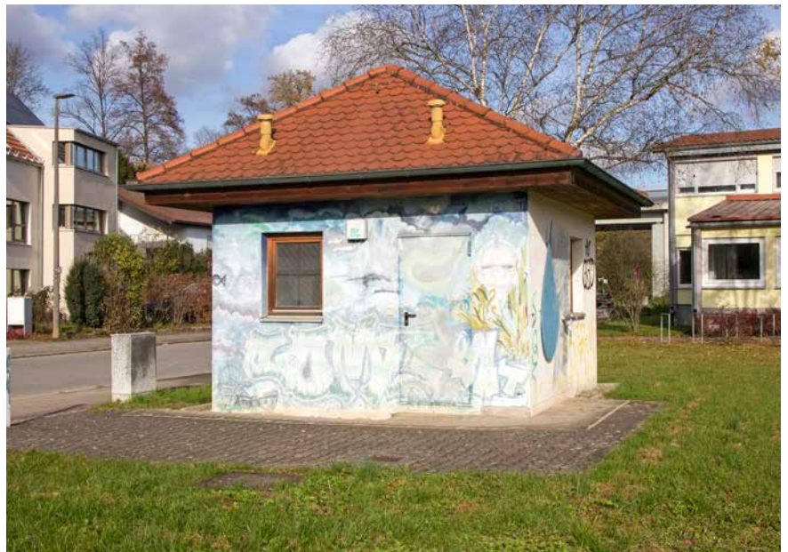
Blick auf das Betriebshäuschen des RÜB Gartenstraße
