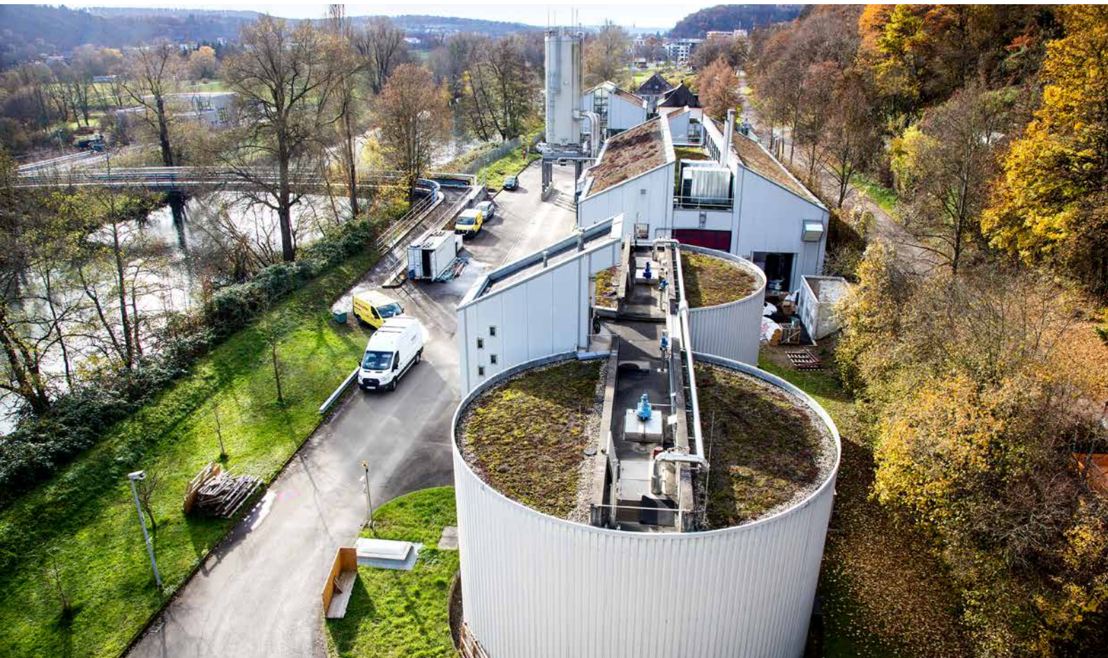
Ein Blick von den Faultürmen auf die Kläranlage und in Richtung Tübingen
