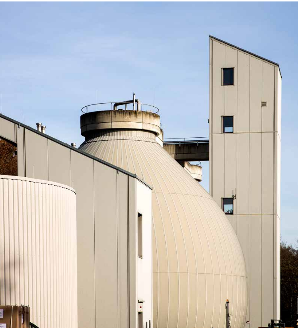
Blick auf die Faultürme als Teil der Schlammbehandlung
