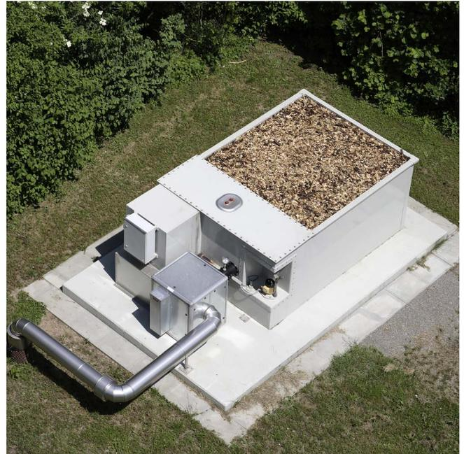
Abbildung 17: Biofilter mit Rindenmulch
