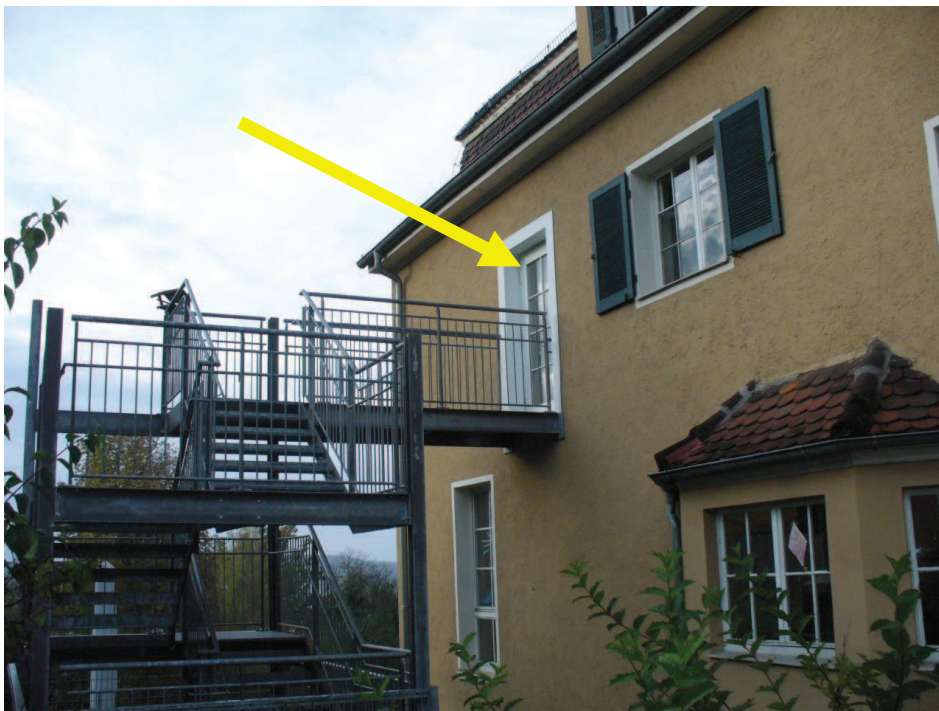
Bild 2: Messpunkt 2.2 (hinter der Notausgangstür)
