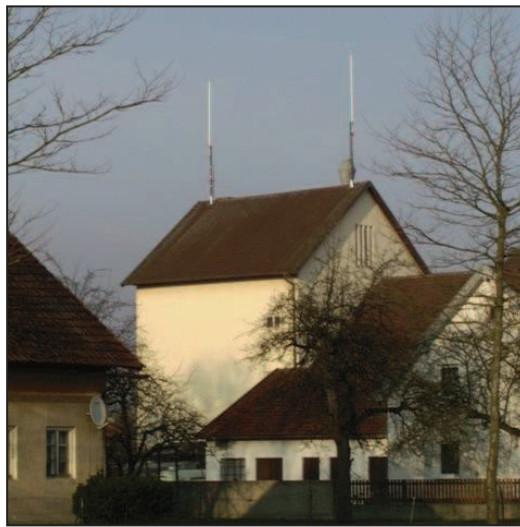
Abb. 1: Beispiel für eine Mobilfunksendeanlage mit omnidirektionalen Antennen.
