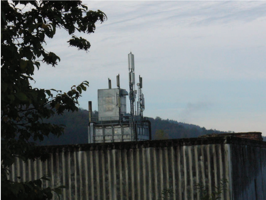
Bild 5: Anlagenstandort 3 von Messpunkt 3.2 aus gesehen
