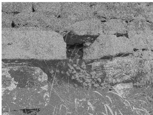
Die Mauern sind im Durchschnitt 1,3 m hoch und erstrecken sich über eine insgesamt Länge von ca. 65 m. Ungefähr 30 lfm hiervon sind sanierungsbedürftig, das entspricht einer Ansichtsfläche von ca. 39 m<sup>2</sup>. Das Steinmaterial ist zum größten Teil noch vorhanden. Mindestens für ein Viertel der zu sanierenden Mauerabschnitte, also für etwa 10 m<sup>2</sup> muss jedoch eine Ergänzung mit neu zu liefernden Steinen eingeplant werden. Die Maßnahme ist folgendermaßen vorgesehen:
