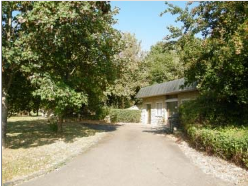
Foto 5: Gebäude der Wasserversorgung mit Grünfläche. Blick nach Westen. (Foto: HPC AG, 14.09.2016)
