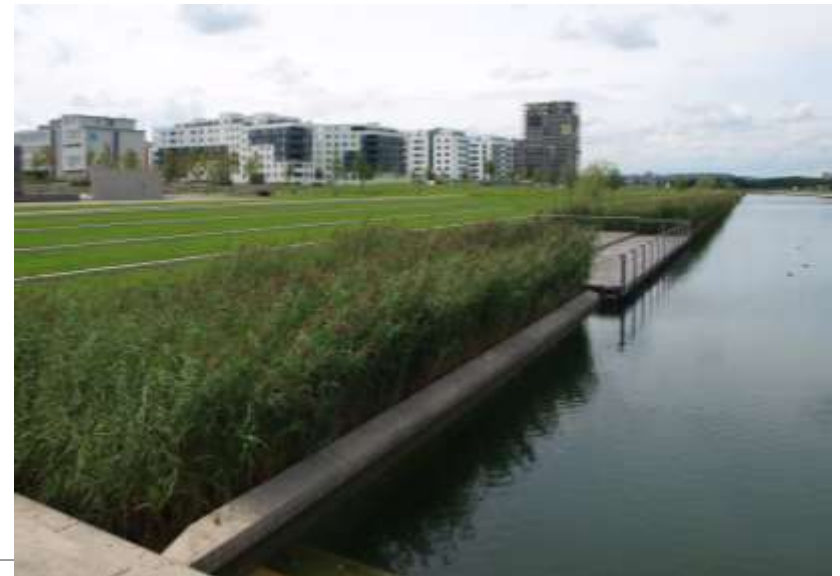
Filterreinigungszone Flugfeld Böblingen
