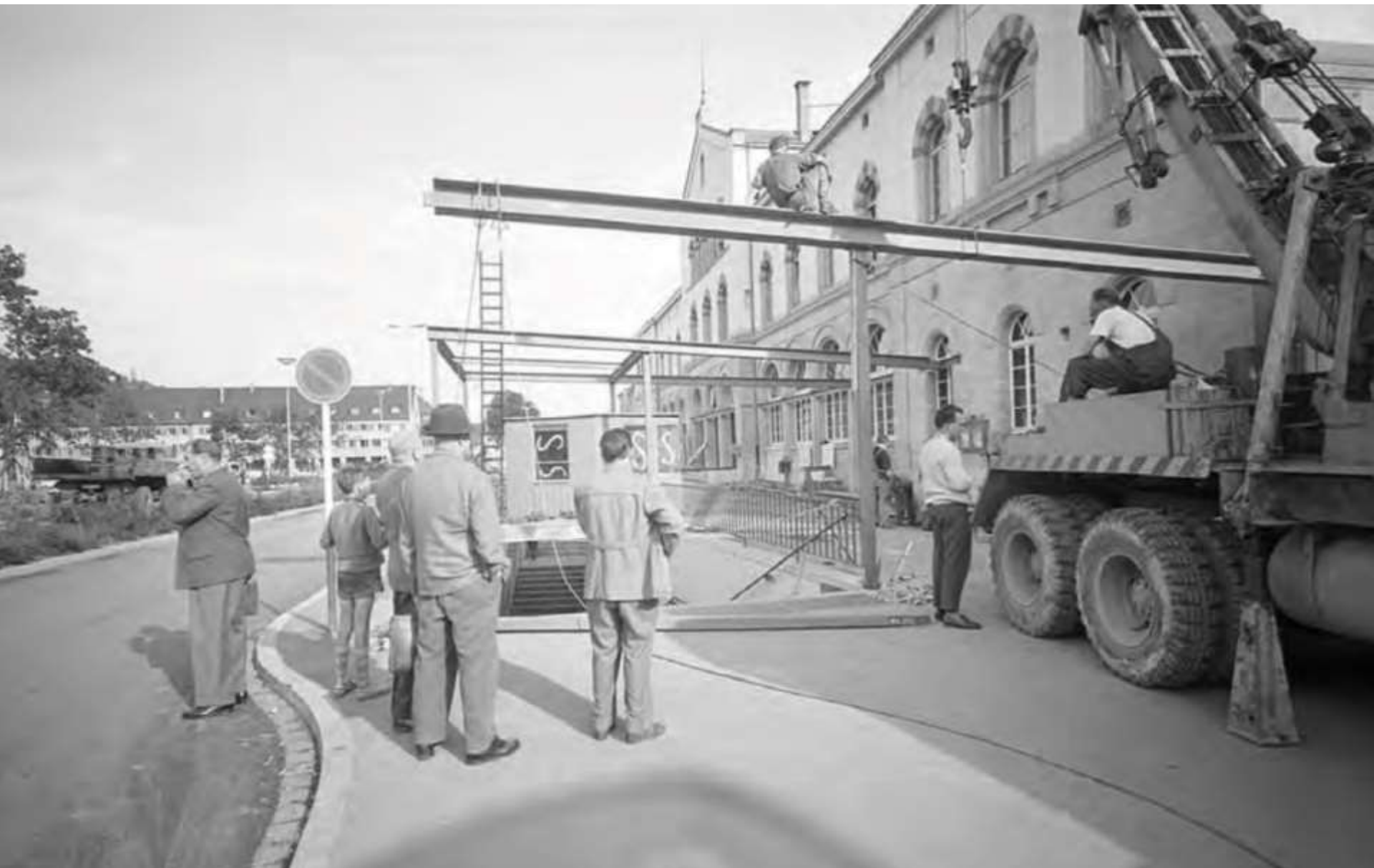
Errichtung des Bahnhofsvordaches, Quelle: Stadtarchiv Tübingen
