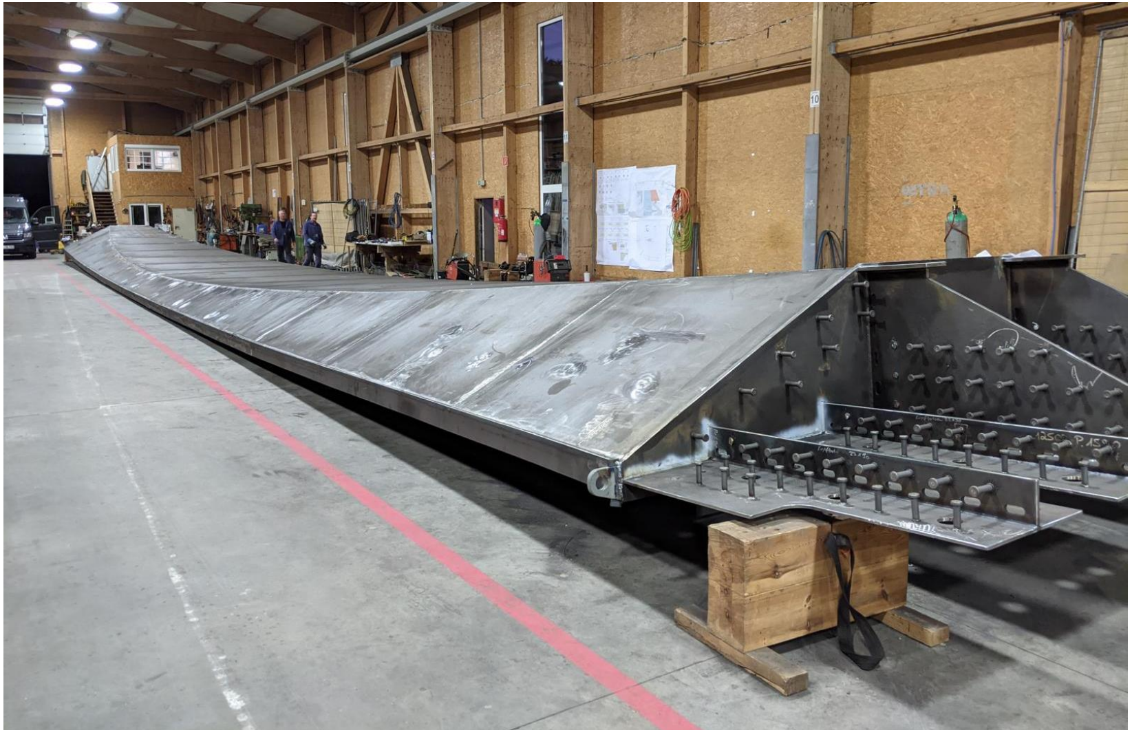
Fertigung des Hauptbauteils der Brücke aus Stahl im Werk
