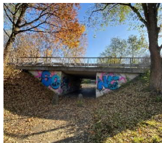
Abb. 27: Unterführung zur Kreissporthalle Tübingen
