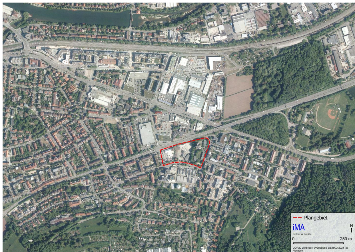
Abbildung 1-2: Luftbild vom Plangebiet sowie der näheren Umgebung.
