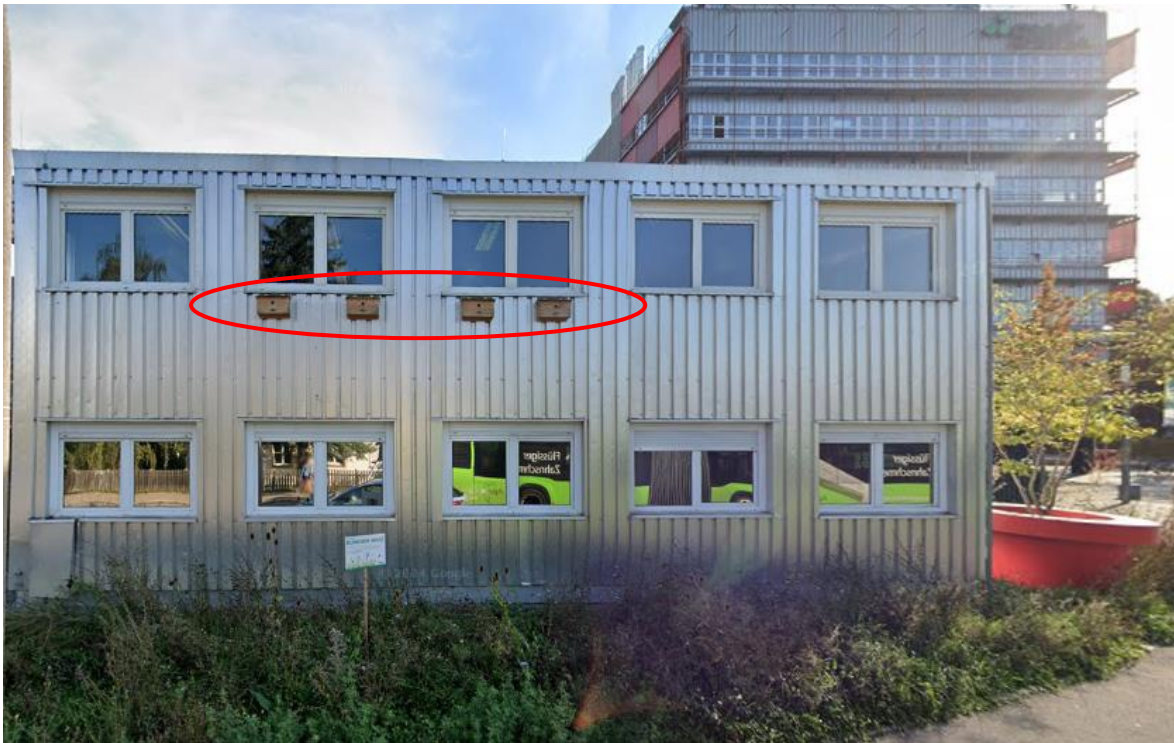
Abb. 4: Nistkästen für den Haussperling am Container der Stadtwerke (CEF-Maßnahme)
