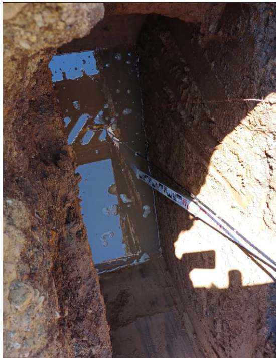
Foto Nr. 5 Versickerungsversuch SG3 - Beginn
