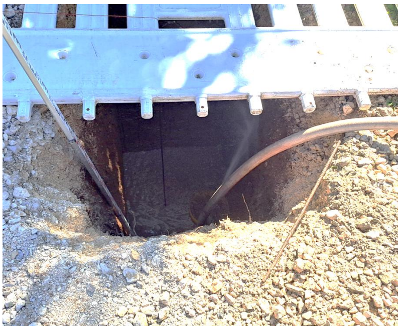
Foto Nr. 3 Versickerungsversuch SG2 - Beginn
