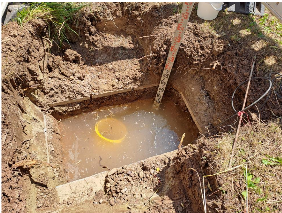
Foto Nr. 7 Versickerungsversuch SG4 - Beginn
