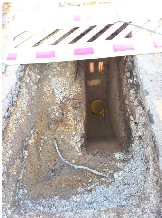
Foto Nr. 6 Versickerungsversuch SG3 – Ende 6,5 h
