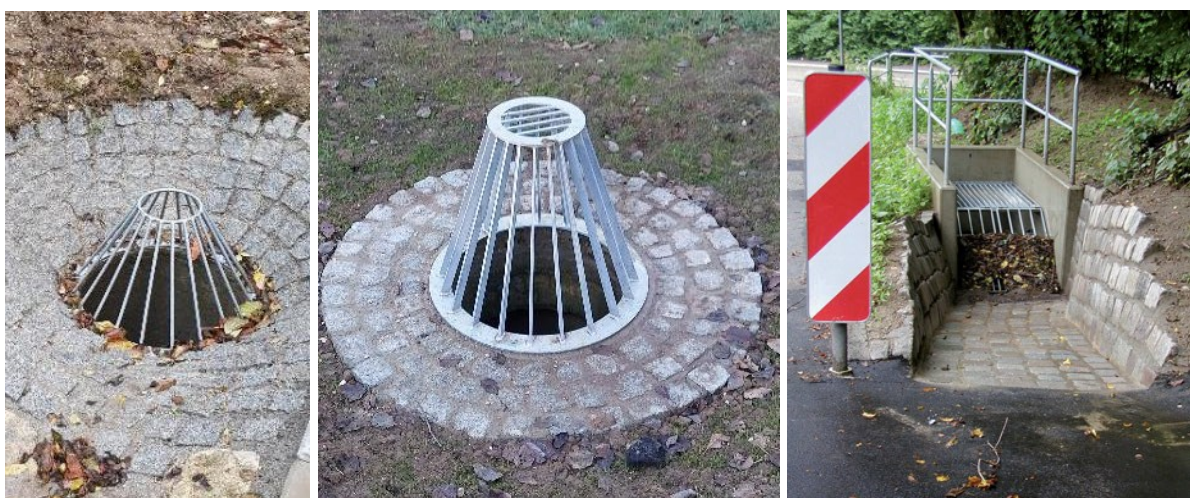
Abbildung 18: Beispiele für Einläufe mit Domrechen (links und Mitte) und Beispiel einer Einlaufsituation nach Karlsruher Modell (rechts; Quelle: DWA 2015)
