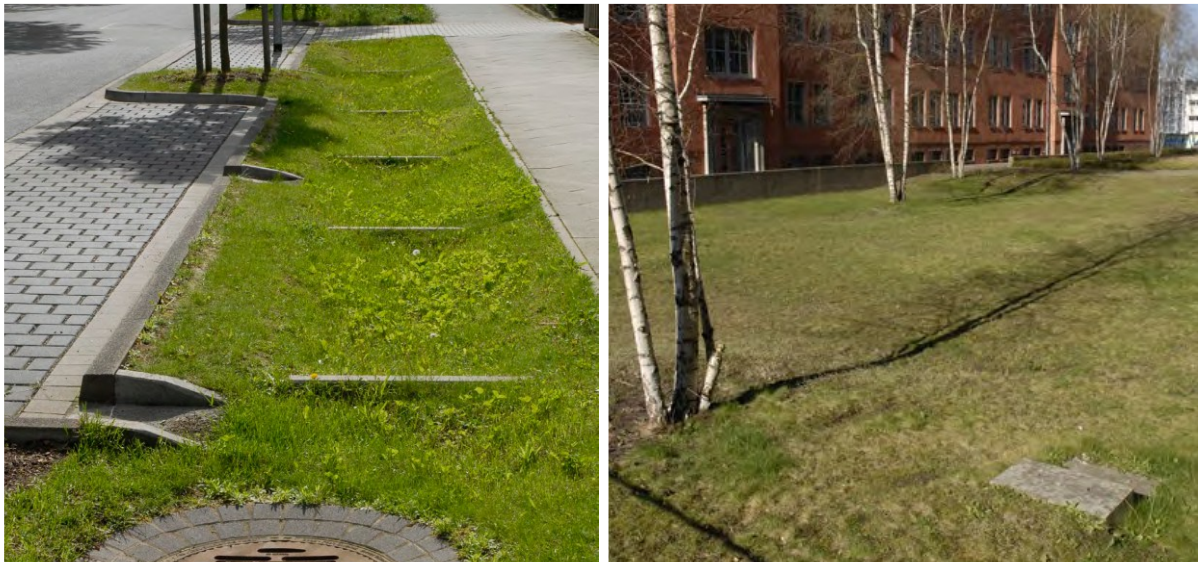
Abbildung 16: Versickerung über Tiefbeete im Straßenseitenraum (links) und Beispiel für eine innerstädtische Retentionsfläche in Berlin-Adlershof (rechts) (Bildquelle: MUST Städtebau, RWTH Aachen Institut für Stadtbauwesen und Stadtverkehr (ISB))
